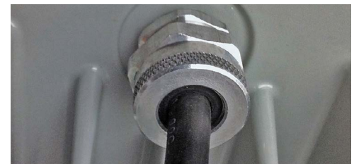
Conjunto de cables precableados de fábrica y agarre del cable para el montaje del yugo
